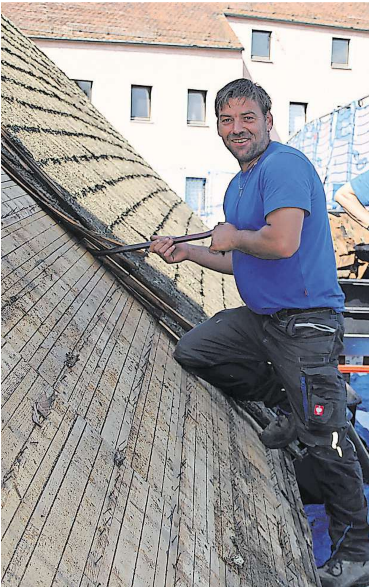
Bevor neue Schindeln verlegt werden können, müssen die morschen weichen.
