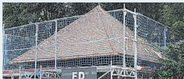
Eine Augenweide: Das sanierte Pavillon-Dach bei der Staudinger-Brücke
